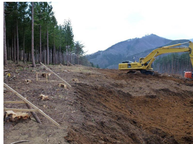
道路の掘削作業
